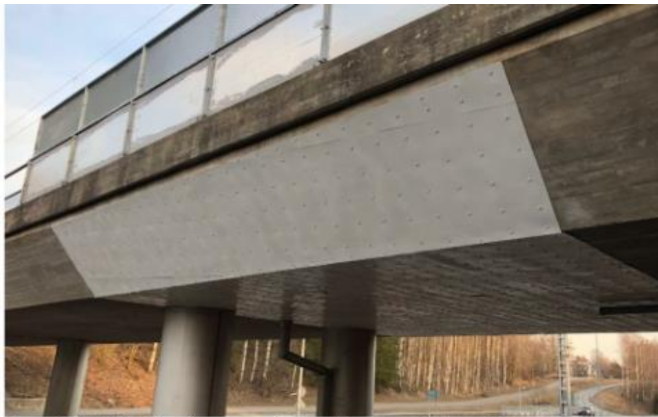
Kuva 2 Ylikulkusilta, jossa on sillan pohjassa eristelevy (Tampere)
