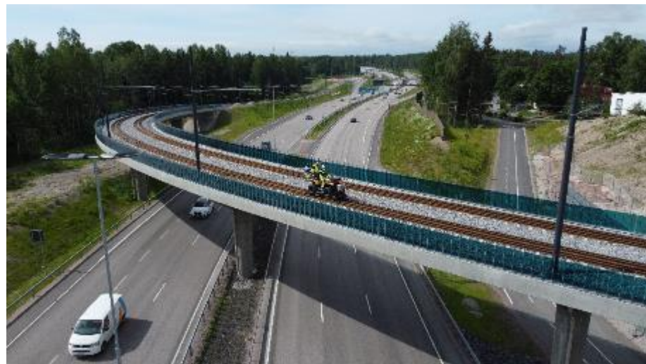
Kuva 7. Räisälänsillalla ATU-keilausta kiskopyörämönkijällä kesä 2022 Lähde: Raide-Jokerin viestintä
